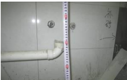
管路施工不规范
