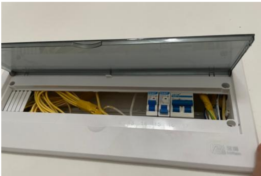
配电箱安装不规范
