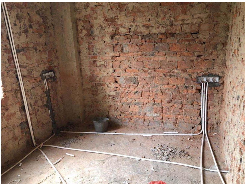
管路施工不规范
